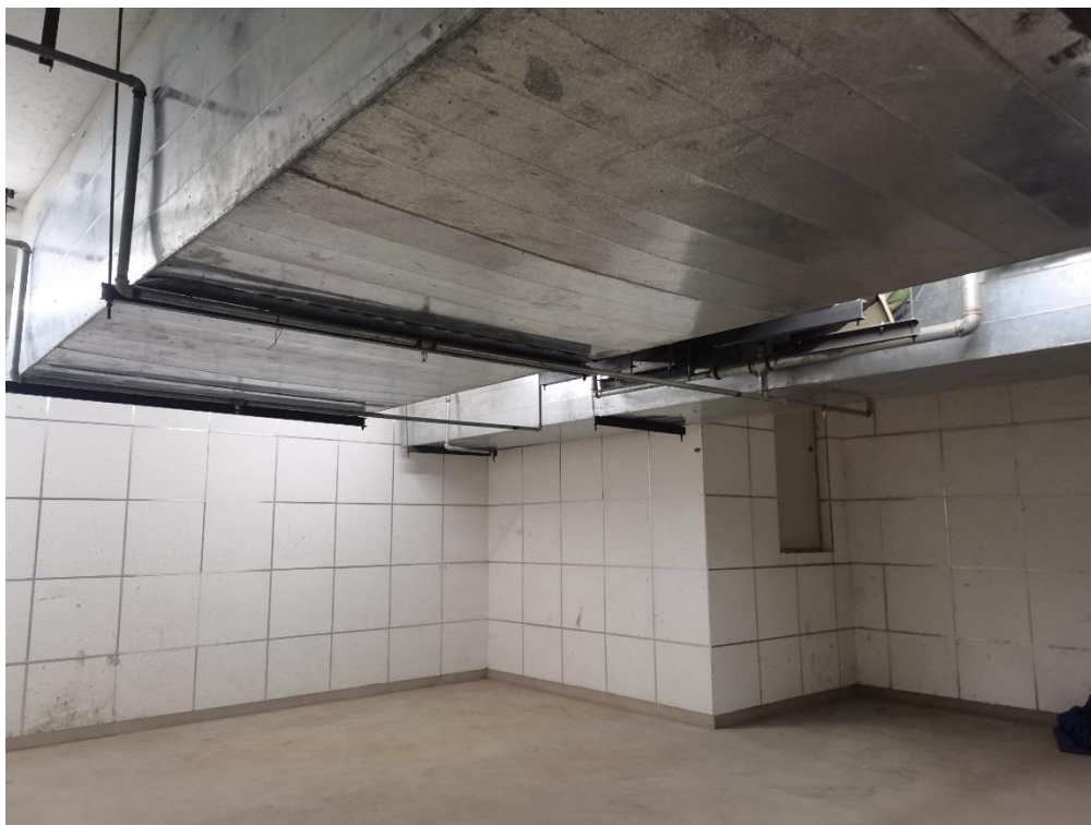
图 4.2-1 地下车库废气收集装置
